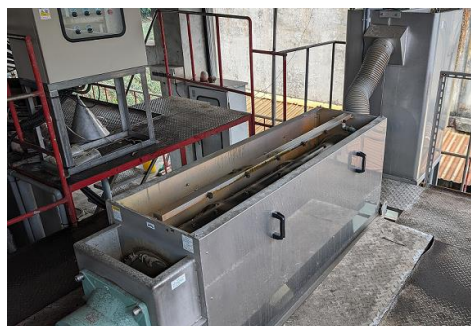
更換新汙泥脫水機
